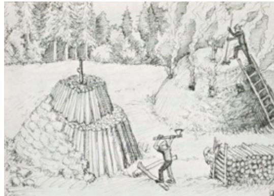
Während der eine Kohlenmeiler noch in Betrieb ist, wird der nächste schon errichtet. Der Energiebedarf in Form von Holzkohle war groß. Die Zeichnung stammt von Anton Köcheler.
