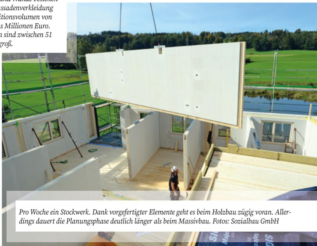
Pro Woche ein Stockwerk. Dank vorgefertigter Elemente geht es beim Holzbau zügig voran. Allerdings dauert die Planungsphase deutlich länger als beim Massivbau. Fotos: Sozialbau GmbH
