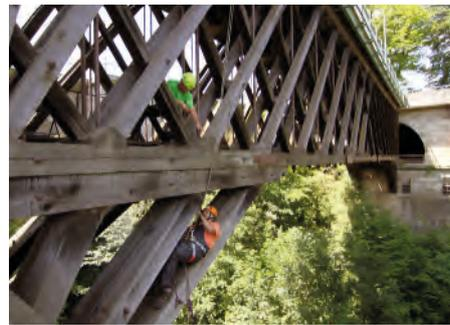
Eisenbahner das vom amerikanischen Ingenieur William Howe entwickelte Fachwerkssystem. Sie verbauten Lärchenholz aus der Schweiz, gewachsen in 1 000 Meter Höhe. Holz wächst dort langsam, hat enge Jahresringe, ist besonders fest und haltbar. Die extrem belasteten Konstruktionsteile baute man aus Eichenholz.
