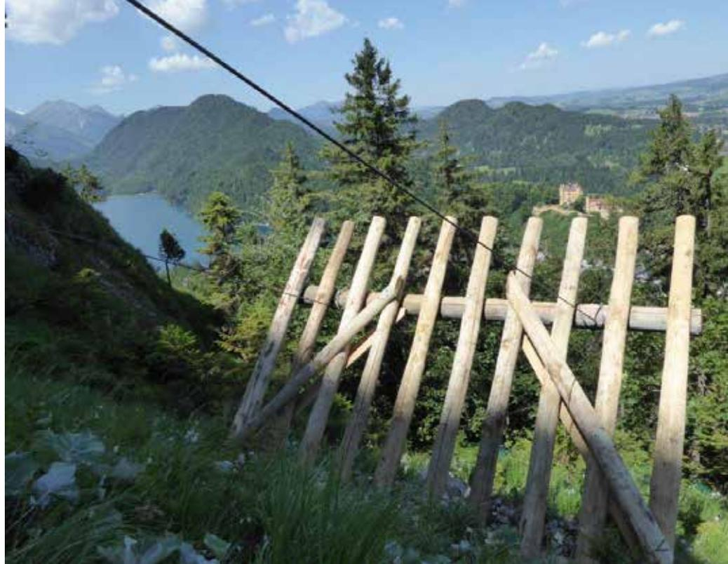
Das Holz der Esskastanie ist eines der langlebigsten Hölzer. Deshalb wird es für temporäre Verbauungen – hier im Ostallgäu – verwendet.
