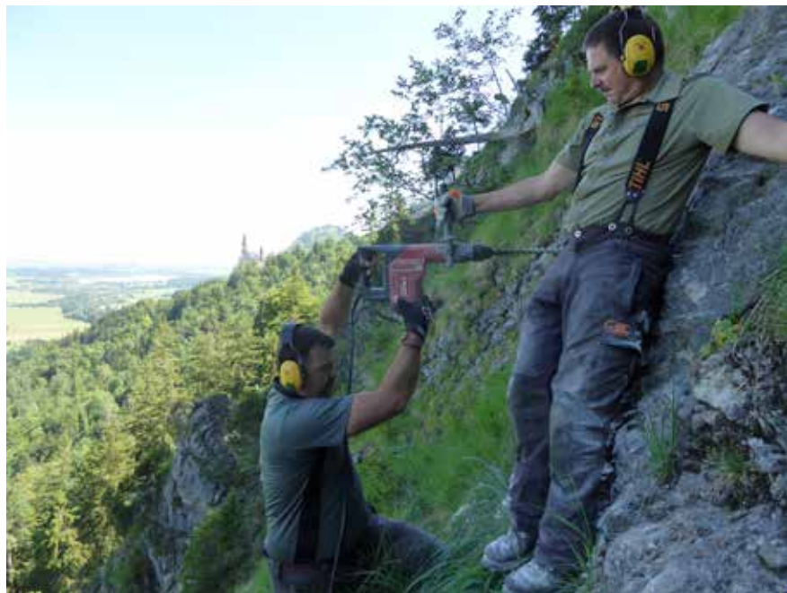
Haben gerade keinen Blick für Neuschwanstein. Die Herren Schömer und Bader treffen Vorbereitungen für die Befestigung eines Hangrechens.
