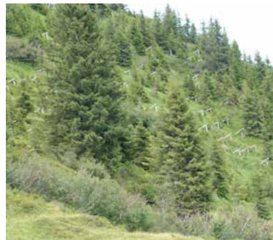
Schutzwaldsanierungsfläche Herzrücken: Im Bild der ehemalige Lawinenanrissbereich (oberhalb der Gaststätte Laiter), der inzwischen mit temporären Verbauungen und Aufforstungen – an dieser Stelle standortgemäße Fichten – geschützt ist.
