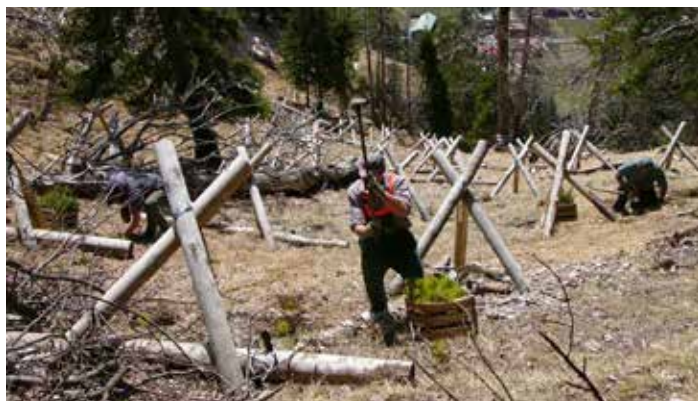
Damit der Wald, der einmal ein Schutzwald sein soll, überhaupt eine Chance bekommt, muss man manchmal – wie hier am Lawinengang oberhalb Hinterstein (Bad Hindelang) – nachhelfen. Die Setzlinge werden durch Dreibeinböcke aus langlebigem Holz geschützt. Spätestens dann, wenn die Böcke verwittert sind, müssen die Bäumchen auf eigenen „Beinen“ stehen. Im Bild von links: Richard Lutzenberger, Florian Karg und Hermann Karg.
